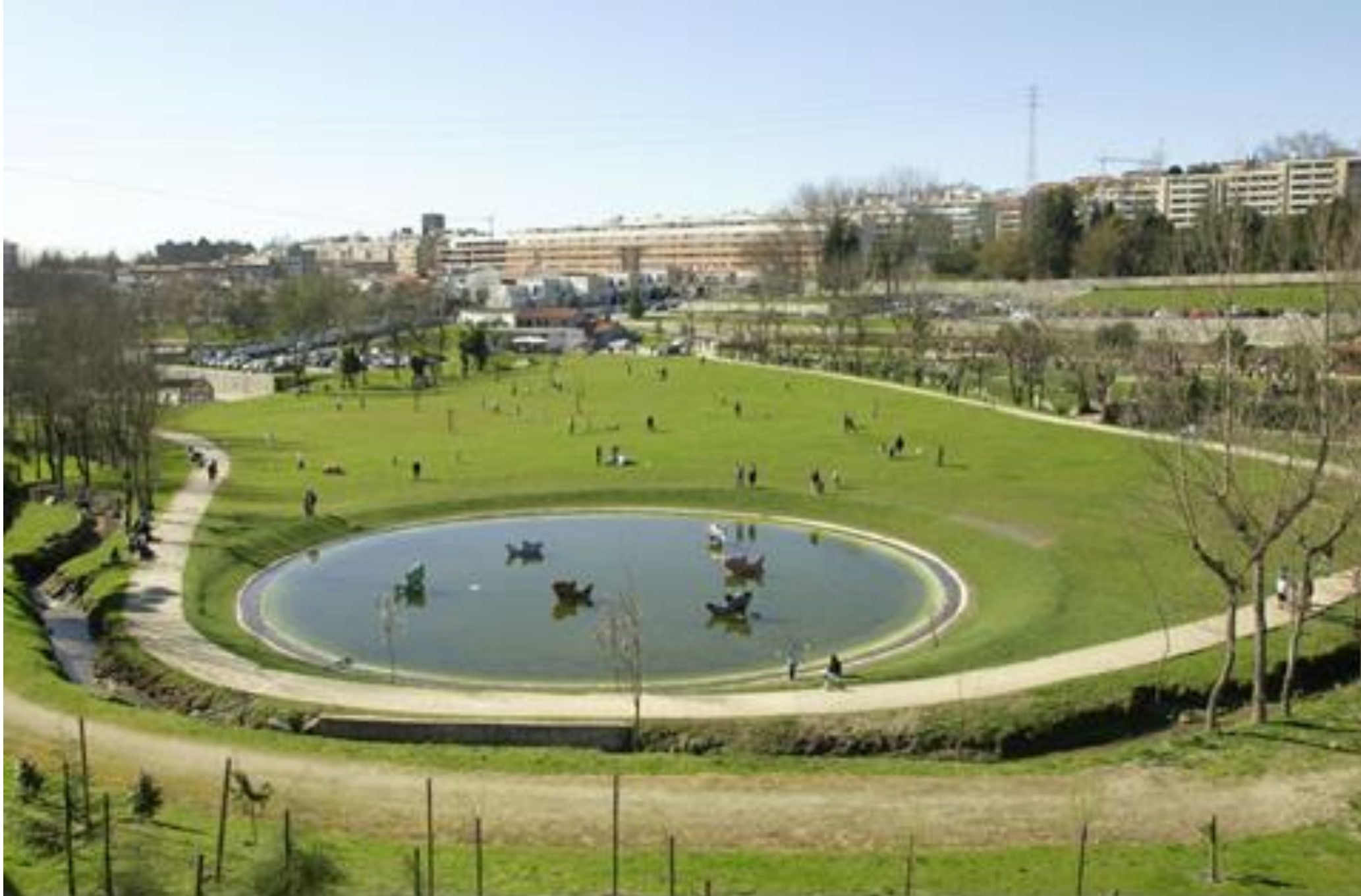
Bacias de infiltração
